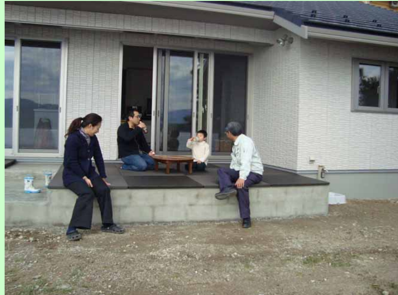
タイルデッキ施工写真(京都府天の橋立)
