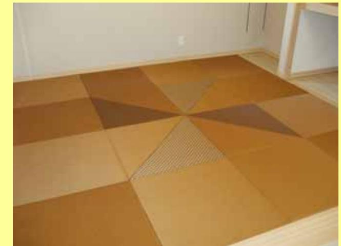
戸建住宅和室施工写真(鹿児島県鹿児島市)
