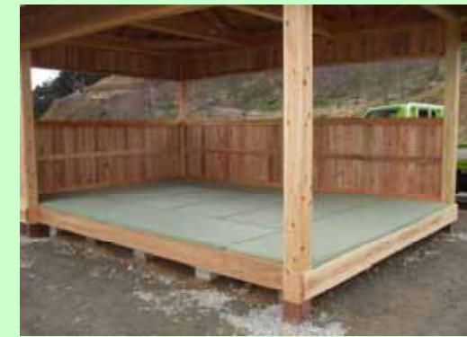
東屋施工写真(佐賀県唐津市)
