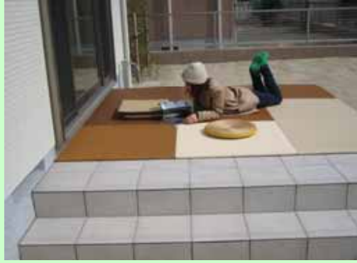
タイルデッキ施工写真(佐賀県佐賀市)
