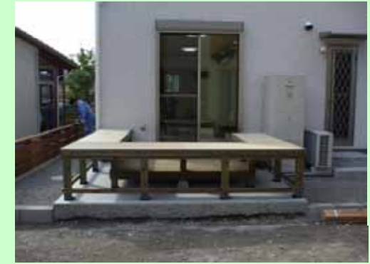
ウッドデッキ施工写真(鹿児島県鹿児島市)
