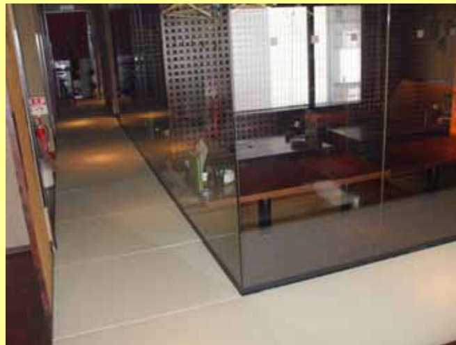
店舗廊下施工写真(東京都豊島区)
