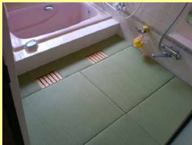
浴室施工写真(福岡県福岡市)
