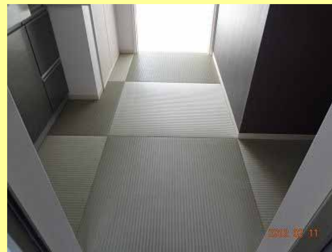
洗面脱衣所施工写真(静岡県三島市)
