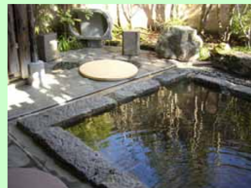
露天風呂施工写真(鹿児島県霧島市)
