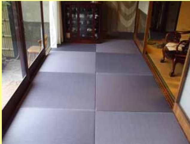
築50年住宅廊下施工写真(福岡県福岡市)
