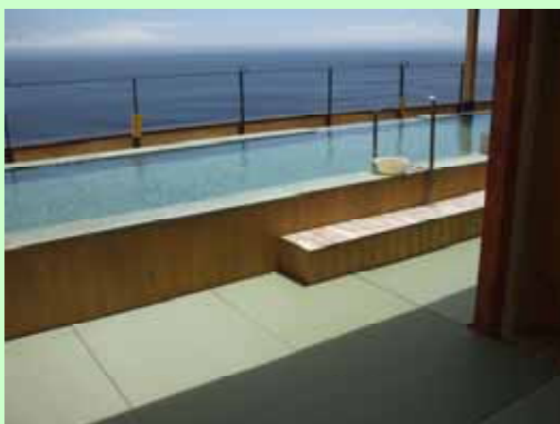
露天風呂施工写真(静岡県伊豆市)
