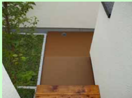
バルコニー施工写真(神奈川県横浜市)
