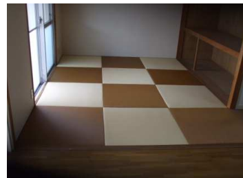
施工後：ユニフロー 写真：M様邸(福岡県福岡市)
