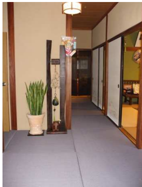
廊下段差解消施工事例 写真：A様邸(福岡県福岡市)
